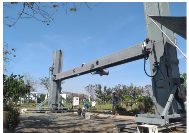
Hình 27. Công nghệ bê tông in 3D dùng cho công trình xây dựng cỡ lớn
