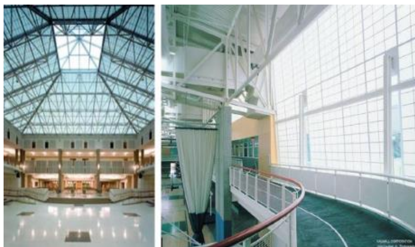
Aerogel trong suốt cách nhiệt trong xây dựng. (Nguồn: Materials Science and Engineering, 2020)
