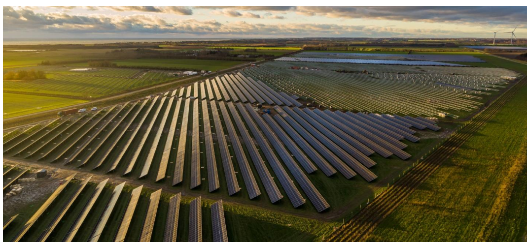
Dự án năng lượng mặt trời Rødby Fjord, đảo Lolland, Vương quốc Đan Mạch (Nguồn: 24/7 Carbon-Free Energy: Powering up new clean energy projects across the globe (Marc Oman and Ignacio Fernandez Stearns, 2022))
