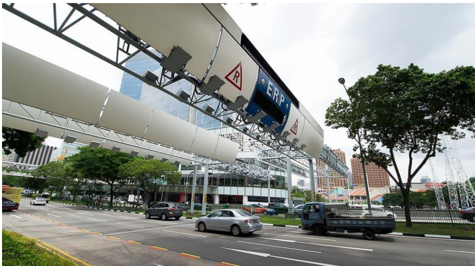
Hệ thống tính phí giao thông điện tử (ERP) sử dụng công nghệ RFID nhằm kiểm soát lượng xe lưu thông giờ cao điểm, tránh tắc đường ở Singapore (Nguồn: Ministry of Transport, Singapore)
