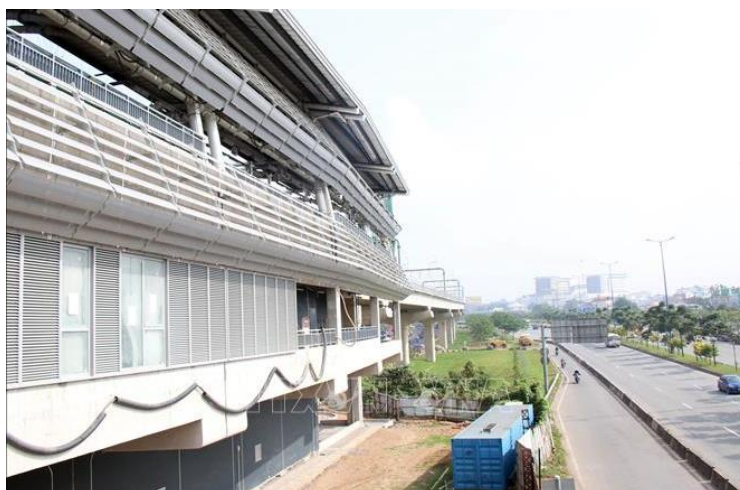
Nhà ga Đại học Quốc gia Thành phố của tuyến metro Bến Thành - Suối Tiên còn nhiều quỹ đất có thể khai thác. Nguồn: Báo tin tức
