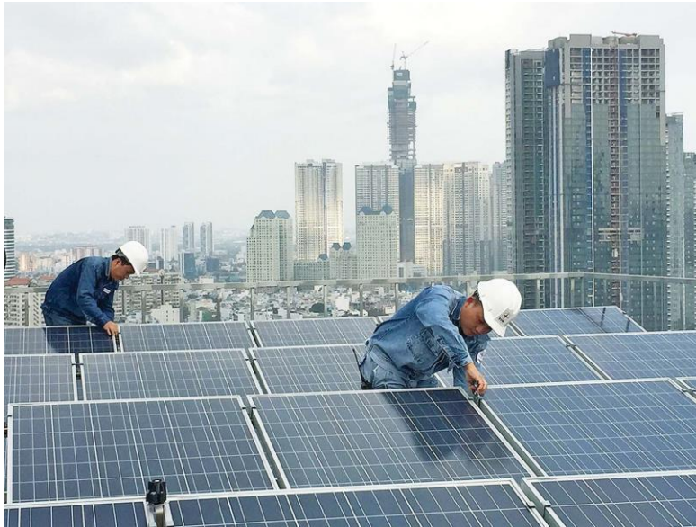
Lắp đặt điện mặt trời trên mái nhà tại TP.HCM
